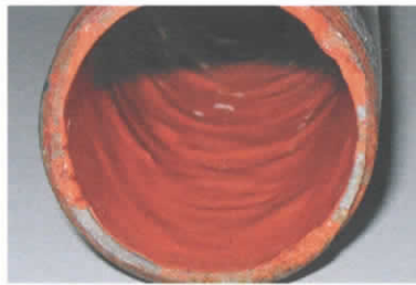
Problematische Oberflächen nach einer Rohrrinnensanierung mit Epoxidharz.
