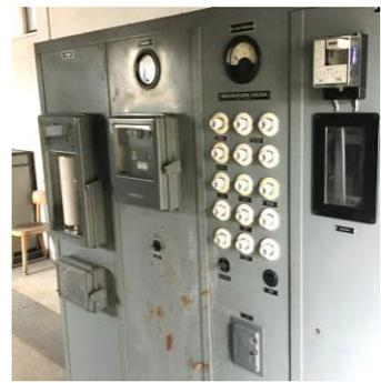
Die Bohrlochpumpe aus dem Jahr 1949 weist diverse Mängel und Schäden auf. Um den Betrieb gewährleisten zu können, muss die Bohrlochpumpe revidiert und der bestehende Motor 500V durch ein Motor 400V ersetzt werden. Mit der Umstellung von 500V auf 400V ist auch der Schaltschrank der Pumpe zu ersetzen und die alte Trafostation rückzubauen. Danach entspricht die Anlage wieder dem aktuellen Stand der Technik.
