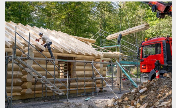
46 Aufrichten der neuen Spitalwaldhütte
