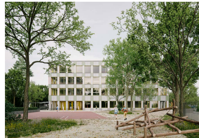
45 Schulhaus Guss Visualisierung Hauptfassade mit Pausenplatz
