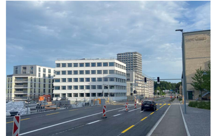
67 Kreuzung Schaffhauser-/Glashüttenstrasse; Inbetriebnahme Lichtsignalanlage
