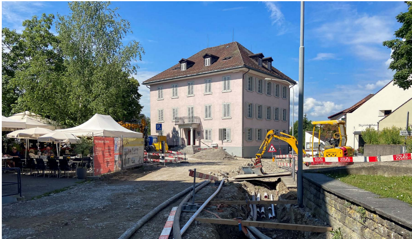
66 Begegnungszone Altstadt 4. Etappe, Hans-Haller-Gasse, Werkleitungsarbeiten
