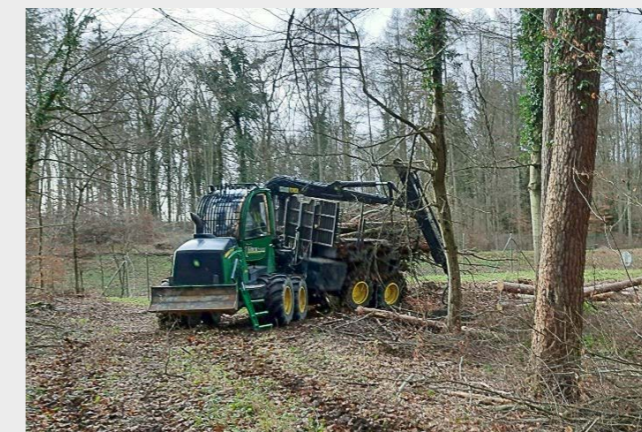
58 Rodungsarbeiten im Bülacher Hardwald
