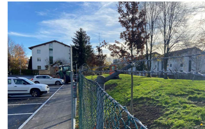
68 Neue Schwimmbadstrasse mit Gehweg und neuen Bäumen
