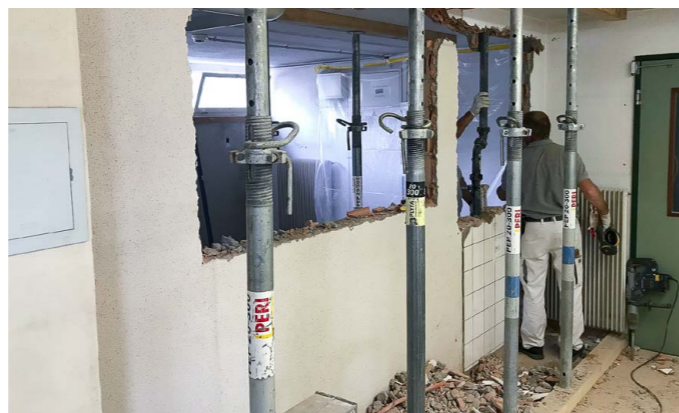
22 Die neue Einsatzzentrale im Rohbau
