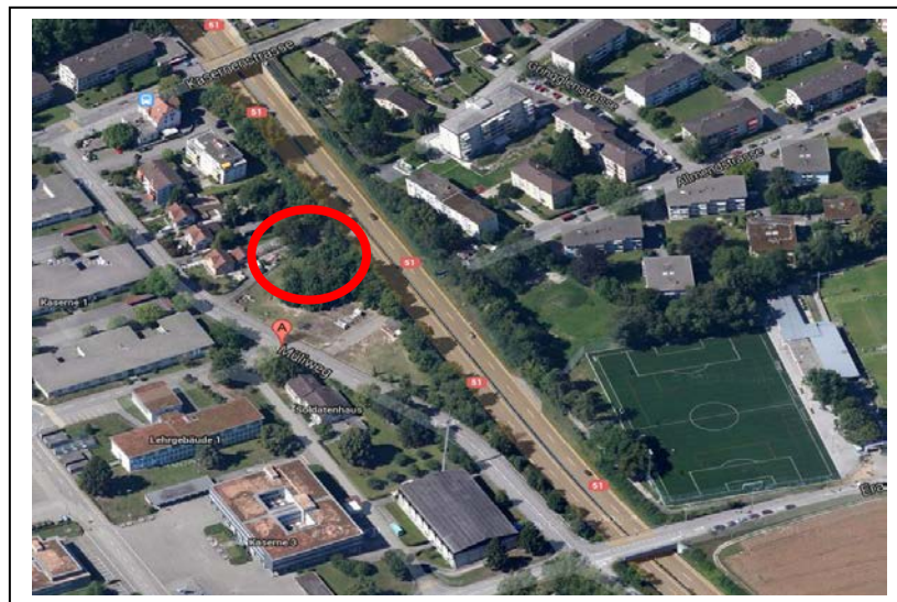
Standort des neuen Zentrums Müliweg
