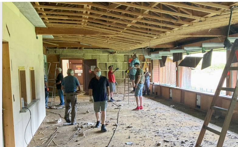
23 Die Pistolenschützen Bülach beim Rückbau
