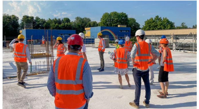
35 Die Abteilung Bildung besucht den Bau der Schulanlage Allmend.
