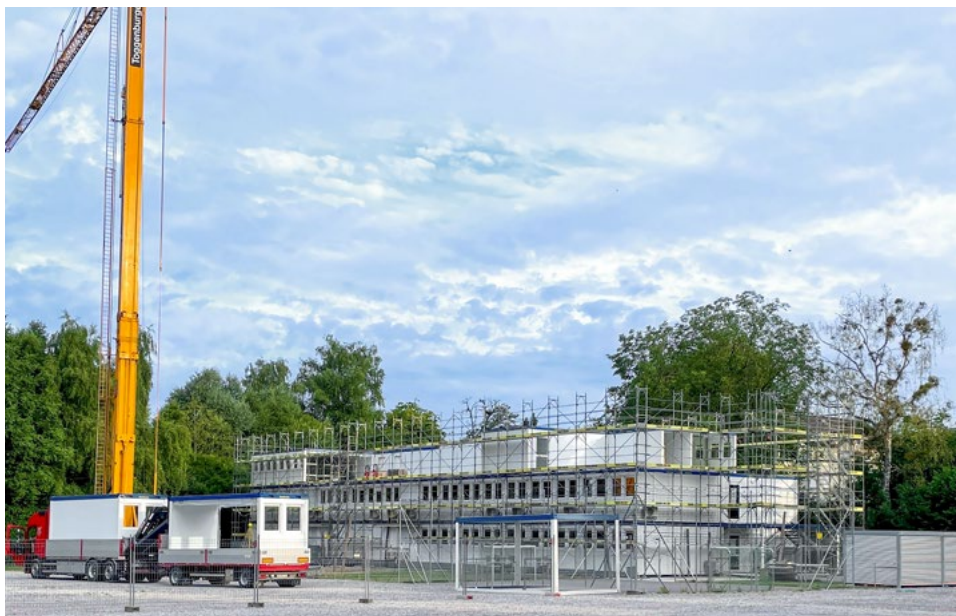
41 Montage der einzelnen Modul-Elemente für die Aufstockung 2. Obergeschoss
