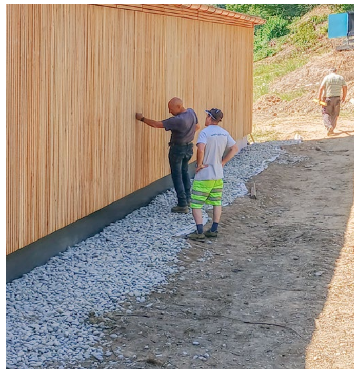
30 Die Fassade der neuen Schiessanlage ganz in Holz
