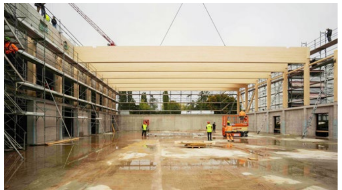
37 Montage der Holz-Träger für das Dach der Dreifach-Turnhalle
