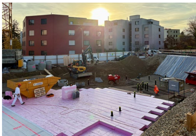
40 Verlegung der Fundament-Dämmung
