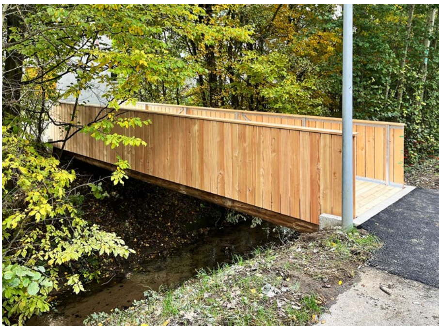
73 Die neue Holzbrücke war innert kurzer Zeit montiert.
