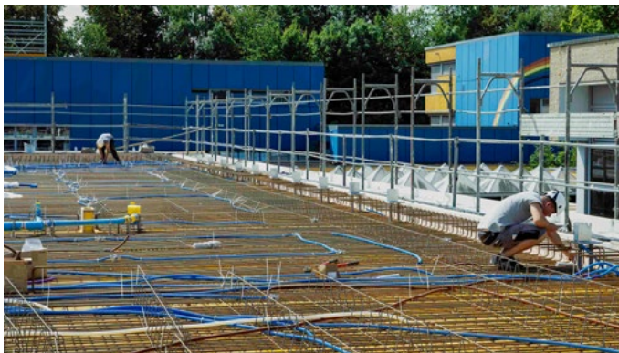
36 Die Bauarbeiten sind in vollem Gange.
