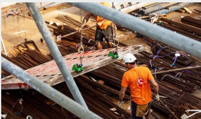
38 Rohbau-Arbeiten mit Schalungselementen und Armierungseisen
