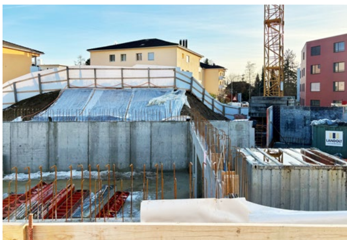
39 Errichtung der tragenden Beton-Wände im Untergeschoss
