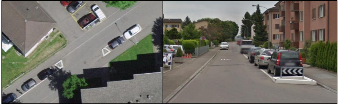
Abbildung 2: Seitliche Einengungen an der Allmendstrasse und am Leeweg (Quelle: Geoweb Gossweiler, Goggle Street View).
