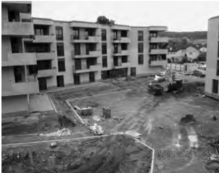
Wohnenplus – Haus Bergli im Bau.
