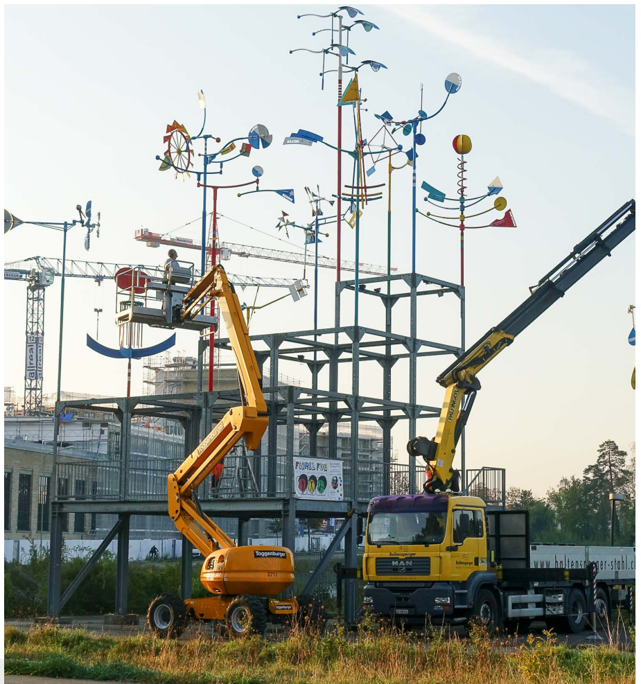
7 Die gesamte Windspiel-Installation hat ein Gewicht von ca. 20 Tonnen und weist eine Höhe von 17 Metern auf.
