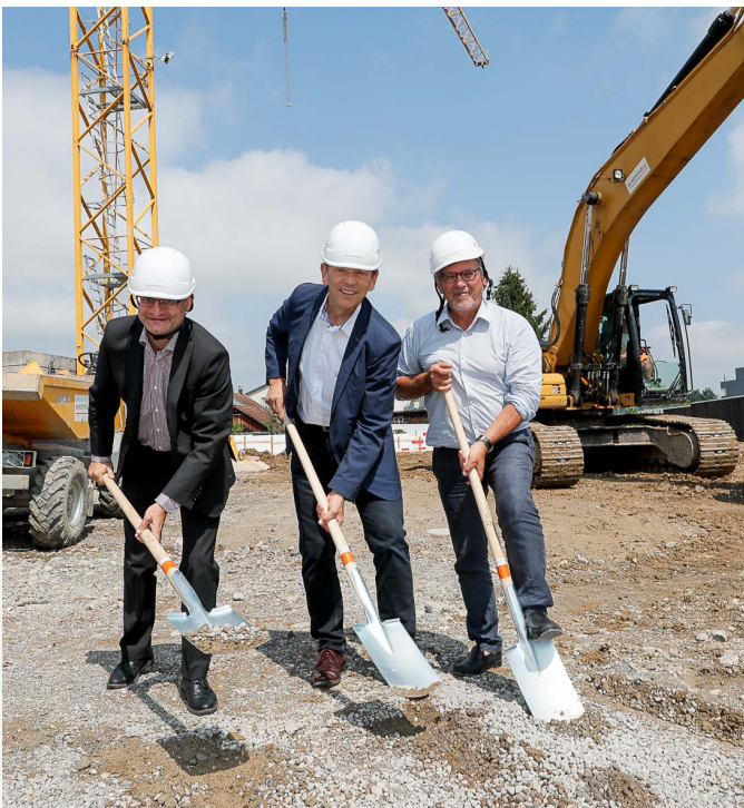
35 Spatenstich: Stadträte Rudolf Menzi (Mitte) und Hanspeter Lienhart (rechts) sowie Daniel Knöpfli, Leiter Soziales und Gesundheit.
