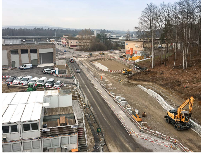
42 Werkleitungs- und Strassenbaustelle an der Fangletenstrasse.
