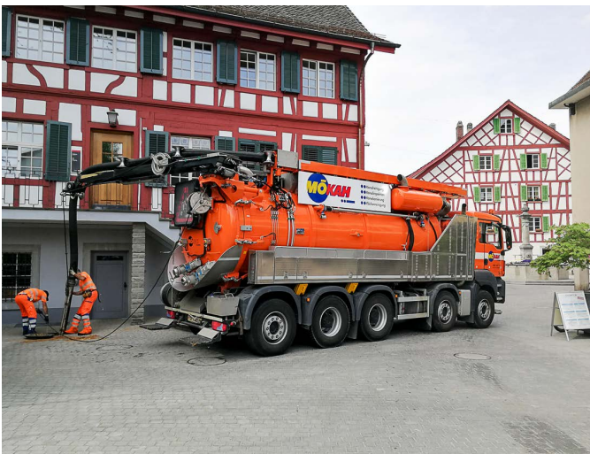
45 Ein Spülfahrzeug im Einsatz.
